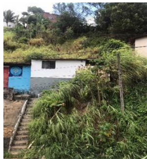
Figura 2. Moradia em Terreno com Perigo de Deslizamento
